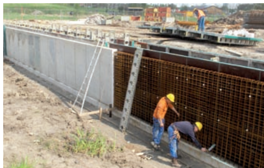
Kroeze Betonbouw bv maakt de betonnen singelbak van 115 meter lang, 2 meter breed en 2,70 hoog in Rotterdam.
