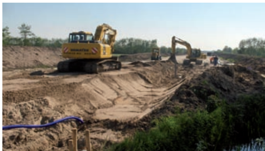
De aanleg van de rondweg Noorder Allee in Sprang-Capelle.
