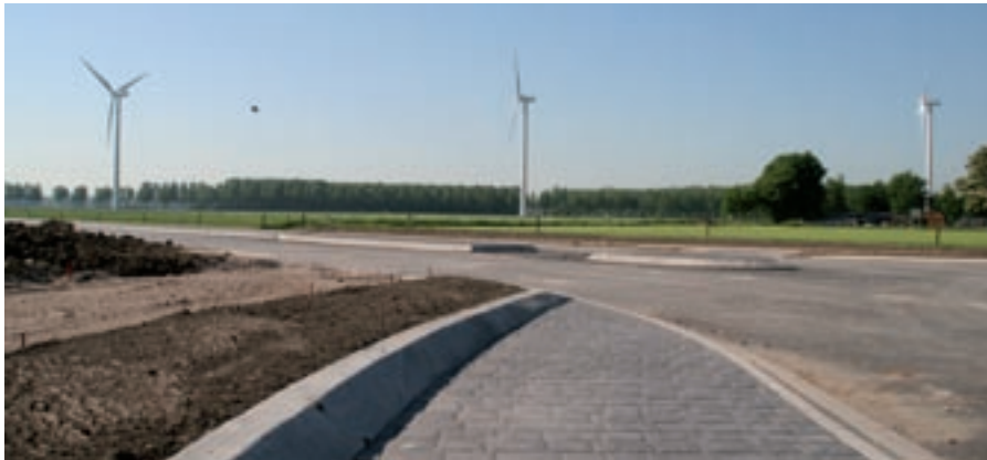
Het aanleggen van de infrastructurele werken op Pavijen V in Culemborg is een uitdagende klus voor Kroeze bv.
