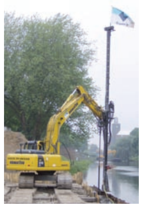
Kroeze bv bracht in Den Bosch een waterremmende laag aan voor een bergbezinkbasin langs de Dommel bij Bastion Maria.
