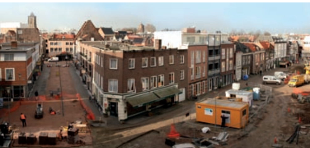
Kroeze Aannemersbedrijf Grond & Wegen geeft het winkelgebied in het centrum van Tiel een facelift.
