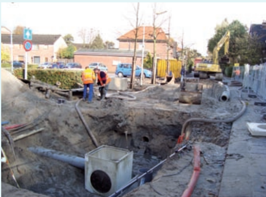
De renovatie van de riolering in het gebied van de Arkelse Onderweg was een uitdagende en ingewikkelde klus voor Kroeze bv.
