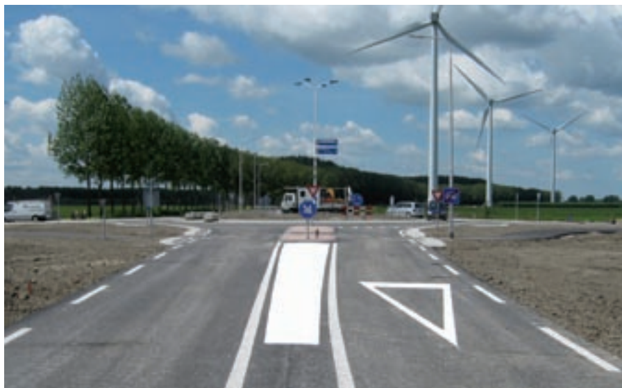
De rotonde die Pavijen V verbindt met de N320 werd 2 weken eerder dan gepland opgeleverd.
