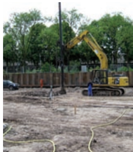
Kroeze Milieu en Injectietechnieken bracht in Den Bosch een waterremmende laag aan voor de bouwkuip van het nieuwe ZLTO gebouw.
