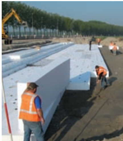
Aanbrengen van EPS voor stabiele onderlaag.
