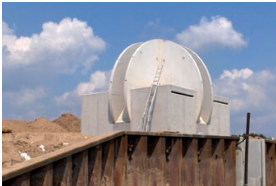
Kroeze Beton maakt in Westervoort de bovenbouw van een gemeal in een voormalige uiterwaard.
