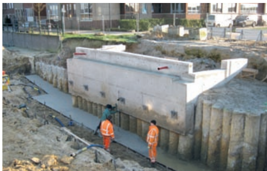
Kroeze Betonbouw is druk bezig met de aanleg van de landhoofden, waar later de brugliggers op worden gemonteerd zodat er een brug ontstaat.
