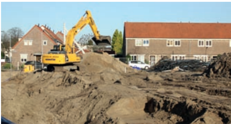
De afgelopen maanden heeft Kroeze het Rioterrein in Tiel gesaneerd en bouwrijp gemaakt.
