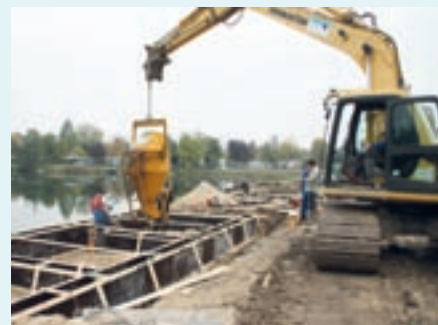
De aanleg van de twaalf nieuwe waterchalets in vrijetijdspark De Ronde te Enspijk.
