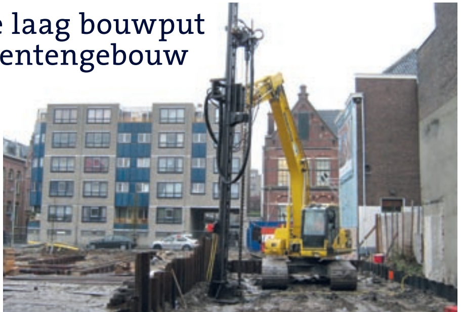
Onder het nieuw te bouwen appartementengebouw Gebroeders Maris in Den Haag bracht Kroeze Milieu- en Injectietechnieken een waterremmende laag aan.
