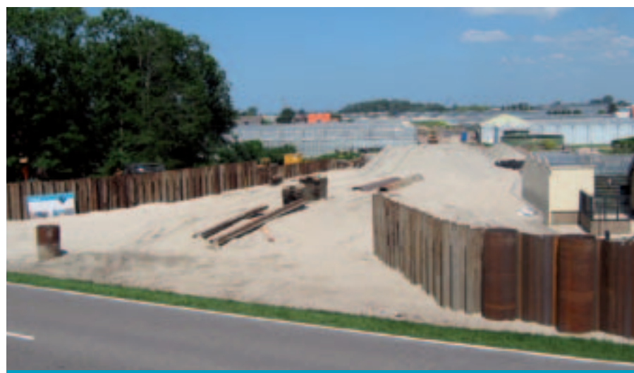
Kroeze bv is in de gemeente Westland druk bezig met de aanleg van damwand-schermen voor de rotonde en de Randweg.
