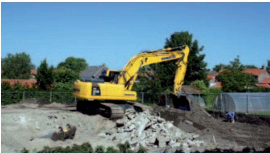
Kroeze Milieu- en Injectietechnieken heeft in dorpskern Meeuwen vervuilde grond afgegraven en afgevoerd voor conventionele sanering.
